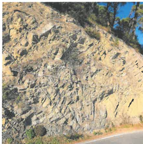
Rivestimento corticale scarpata rocciosa
